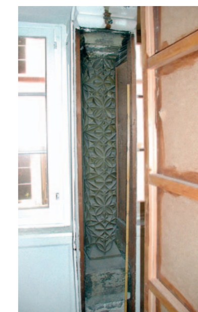
Hinter Täferverkleidung entdeckt: Fenstersäule des 16. Jahrhunderts.
