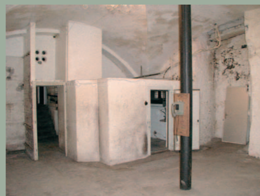
Der tonnengewölbte Keller mit der Gusseisensäule.
