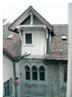
Oben: Aufzugsgaube über sekundär eingebauten gotischen Fenstern. Unten: Nordfassade. Massstab: 1:200.
